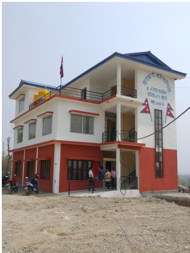
नवनिर्मित ६ नं वडा कार्यालय भवन
