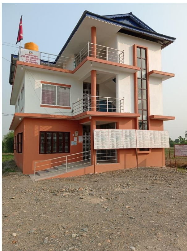
नवनिर्मित ७ नं वडा कार्यालय भवन
