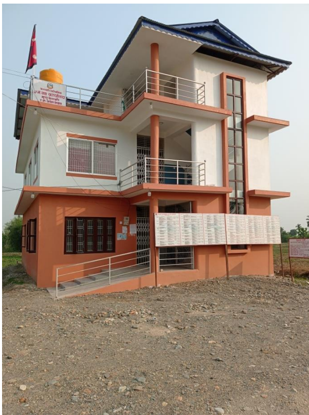
नवनिर्मित ७ नं वडा कार्यालय भवन
