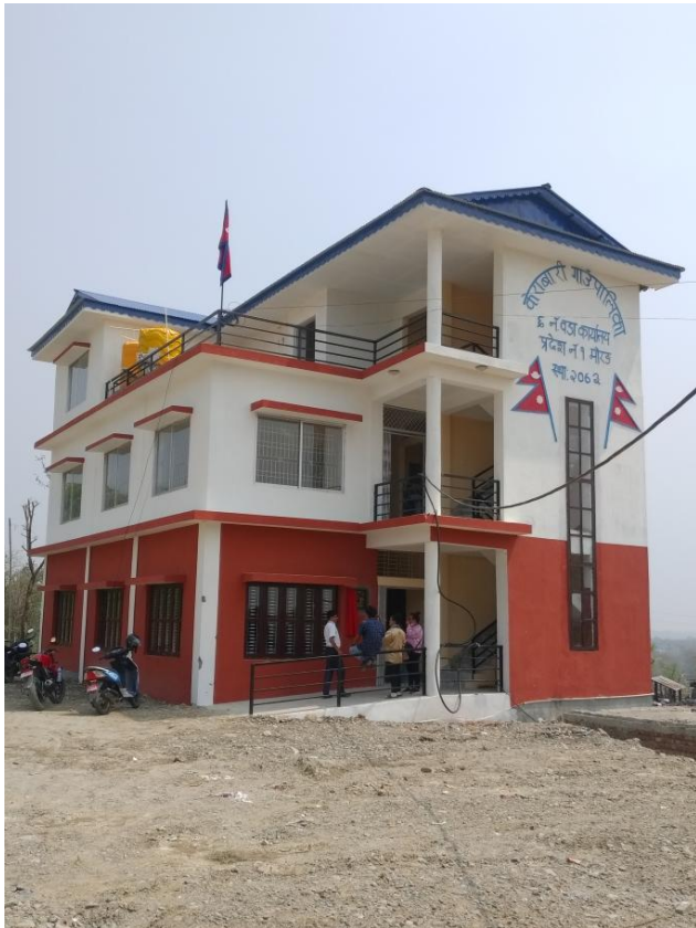
नवनिर्मित ६ नं वडा कार्यालय भवन
