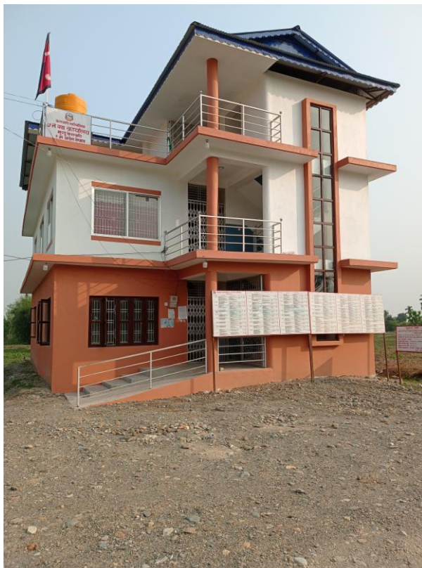
नवनिर्मित ७ नं वडा कार्यालय भवन
