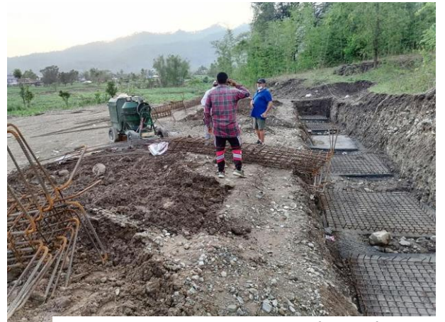
प्रशासकिय भवन निर्माण कार्य
