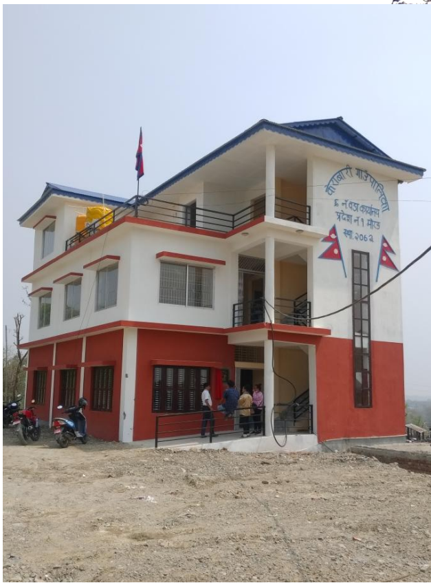
नवनिर्मित ६ नं वडा कार्यालय भवन
